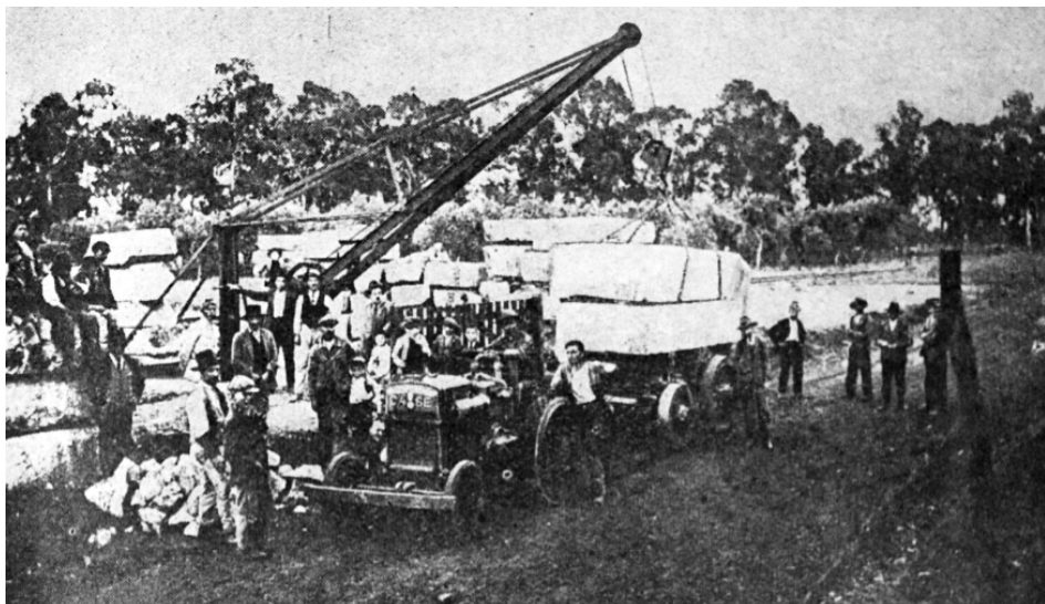
Figura 2 - Pedreira de mármore na zona da Vigária, Vila Viçosa. Equipamento de condução e transporte de mármore (1929) 19
