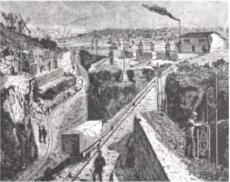
Figura 9 - Uso de fio helicoidal numa pedreira belga, 1885 18
