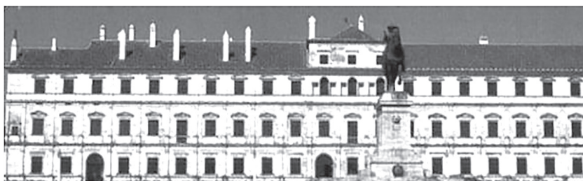
Figura 3 e 4 - Fachada do paço ducal de Vila Viçosa (campanha de revestimento de mármore de início do século XVII, sob direção do arquiteto Pero Vaz Pereira).
